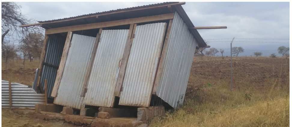
Die neuen Schultoiletten im Bau (oben) und die umgestürzten alten Toilettenhäuschen (unten)
